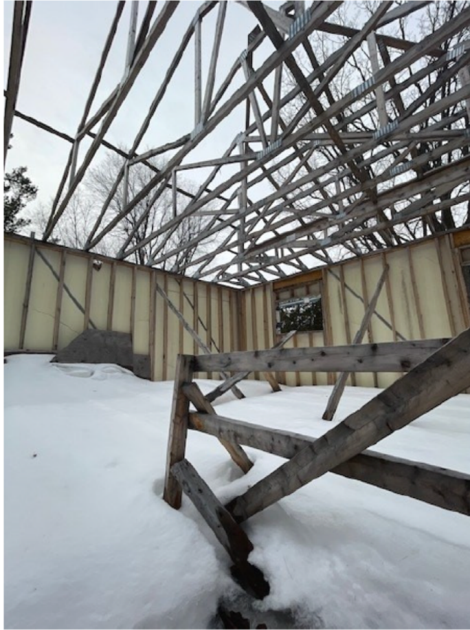
Photo 1 : Éléments de charpente de bois noircis
