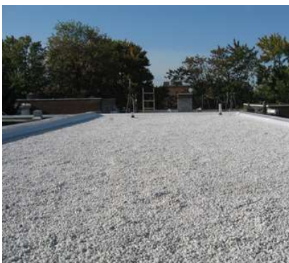
Toits blancs (gravier) / White gravel roof
