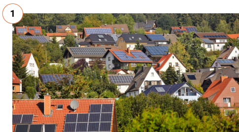
Panneau solaire / Solar pannels
