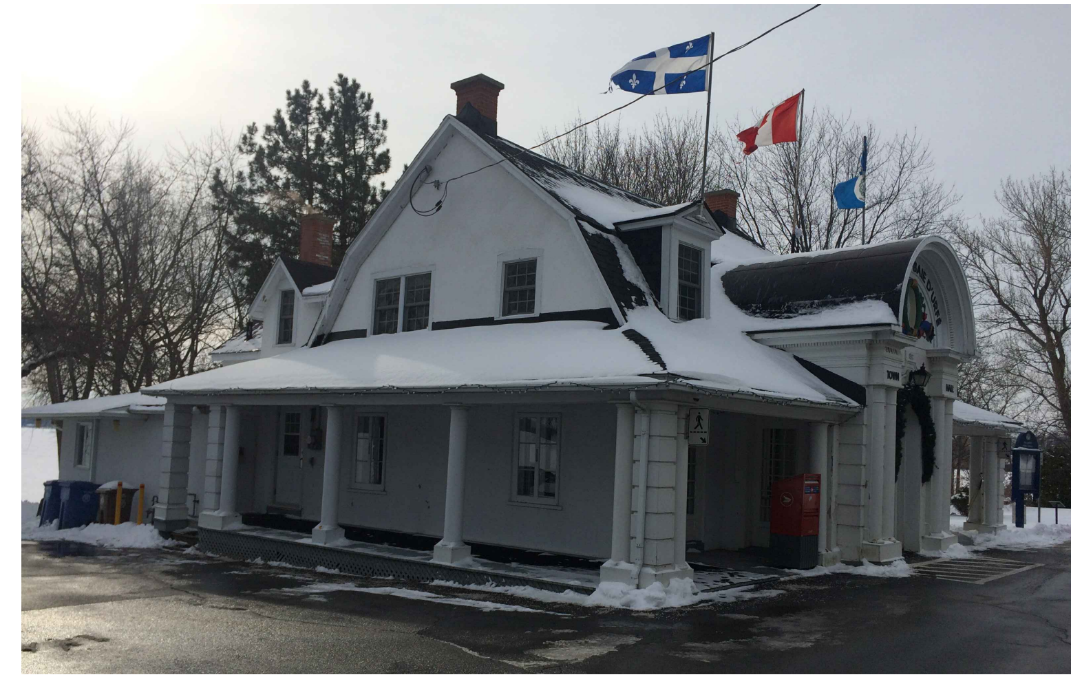
CONDITION ACTUELLE - FAÇADE PRINCIPALE
