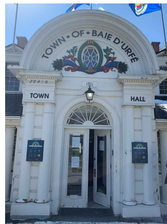
06 CONDITION EXISTANTE N.A.
