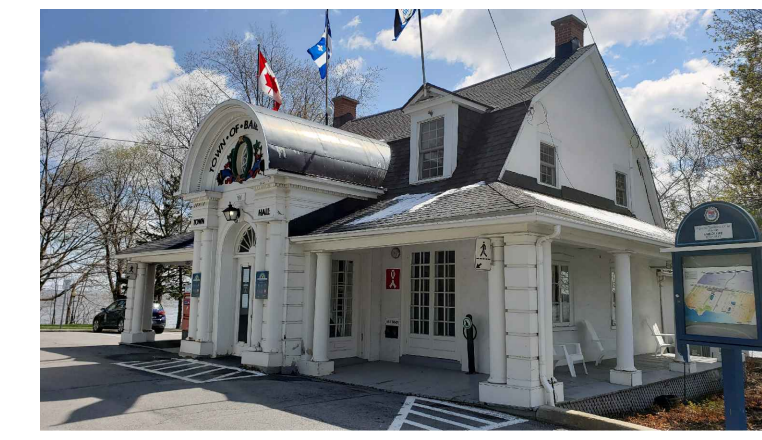
Vue générale de l'avant - élévations nord et ouest
