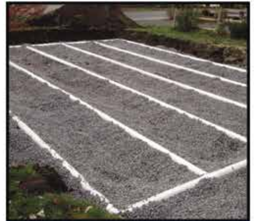
Septic system installation, Installation de système septique
