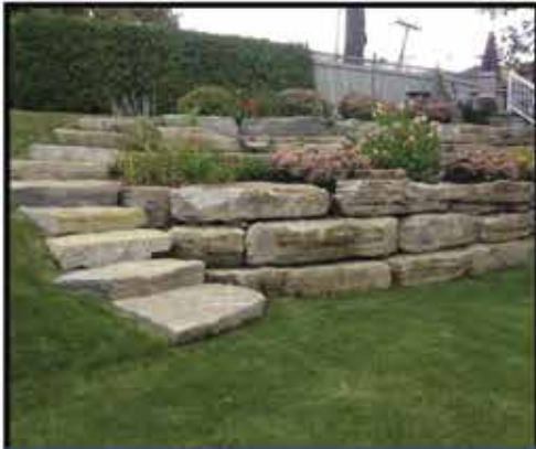
Pointe Claire 2012: Natural stone retaining walls with stairs and planting areas Murs de retenue en pierre naturelle avec escaliers et espace de plantation
