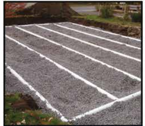
Septic system installation, Installation de système septique
