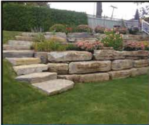
Pointe Claire 2012: Natural stone retaining walls with stairs and planting areas Murs de retenue en pierre naturelle avec escaliers et espace de plantation
