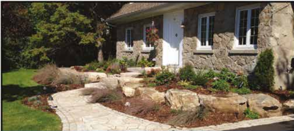
Baie D'Urfe 2014: Paving stone walkway with planting areas, asphalt driveway with paving stone borders - Patio en pierre de pavement avec espaces de plantation
