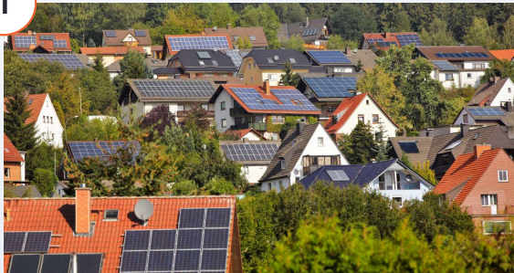
Panneau solaire / Solar panels
