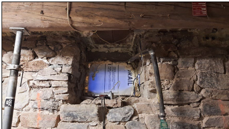
Photo 19. Détail du parement intérieur du mur ouest du bâtiment. On y aperçoit l'une des poutres de thuya occidental ainsi que l'ancienne ouverture menant à l'extérieur, aujourd'hui condamnée. Vue vers l'ouest. (BiFI-18-23-N2-25).
