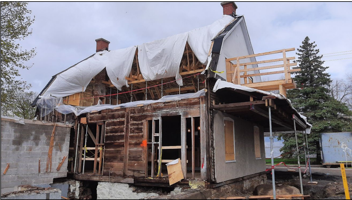
Photo 17. Vue arrière du bâtiment actuel, lors des travaux de réfection. On y aperçoit la structure faite de madriers de bois (BiFi-18-23-N2-43).
