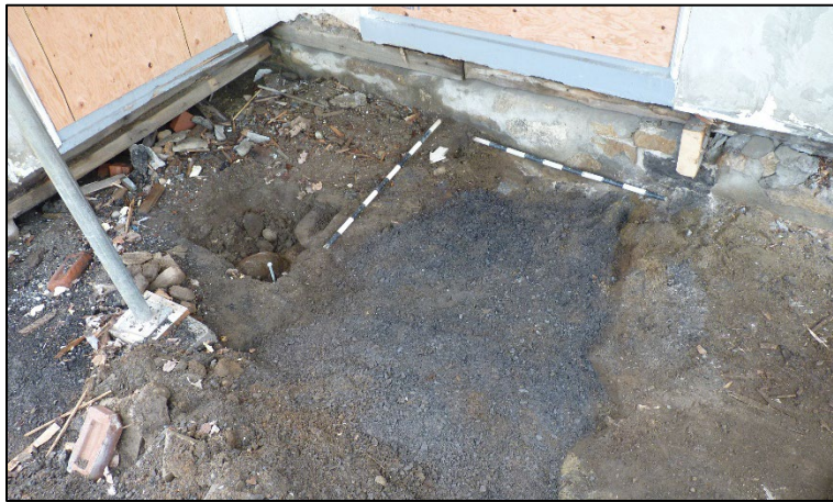
Photo 24. Sous-opération 1B. Aperçu de la tranchée d'implantation pour l'alimentation en eau de gicleurs automatiques. Vue vers le sud-est (BiFI-18-23-N1-98).
