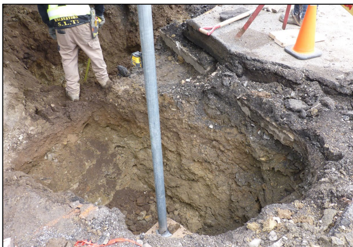
Photo 1. Sous-opération 1A. Le sol naturel stérile, de couleur brun jaunâtre, est bien visible. Vue vers le nord-ouest (BiFI-18-23-N1-300).
