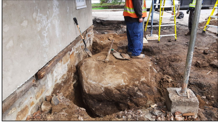
Photo 18. Sous-opération 1A. Imposant rocher d'origine naturelle, adossé au mur est du bâtiment de l'hôtel de Ville. Vue vers le nord (BiFI-18-23-N2-6).
