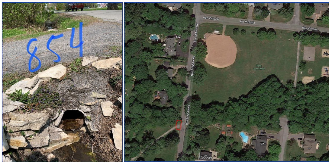
Figures 13 : Ponceau existant en TTOG, rue St-Andrews
