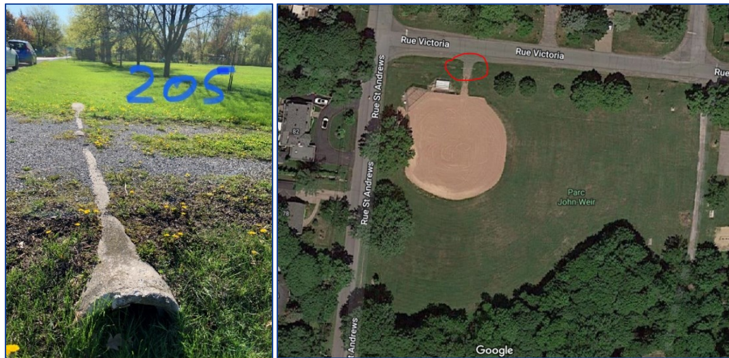
Figures 11 : Ponceau existant en béton, rue Victoria
