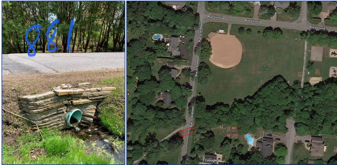
Figures 12 : Ponceau existant en PVC, rue St-Andrews
